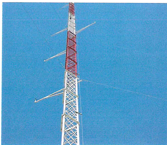
Photo 1 : Détail de la structure treillis d'un mât de mesures
