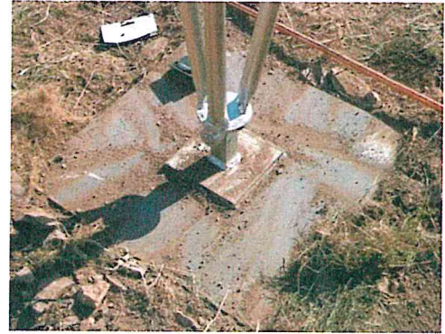
Schéma et Photo 2: Détail de l'embase d'un mât de mesures (photo de la partie émergente).
