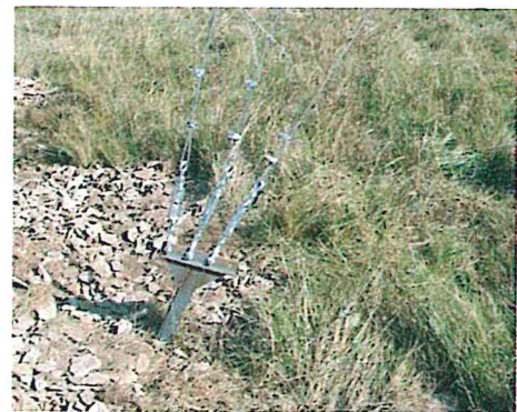
Schéma et Photo 3 : Détail de l'ancrage des haubans (photo de la partie émergente).
