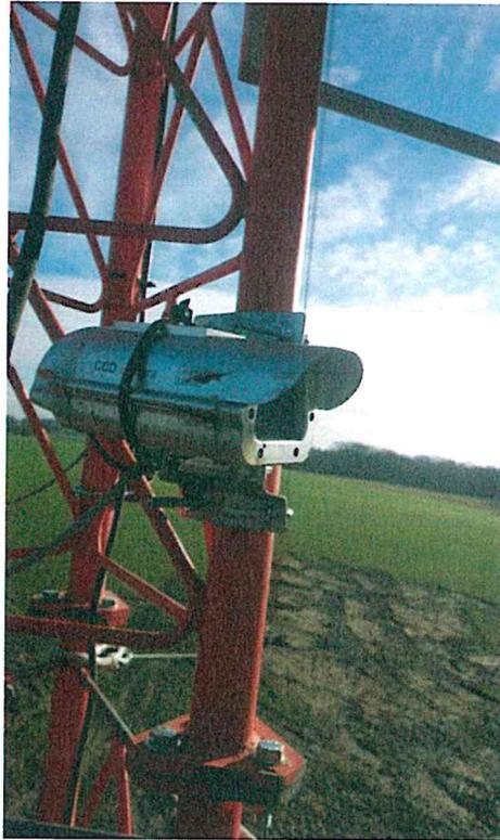
Photo d'un feu de balisage, fixé à mi-hauteur du mât :
